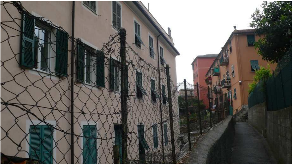
Vista generale fabbricato retro - Fotografia n° 2
