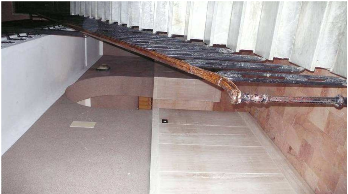
Vista generale piano terra partenza scala di accesso ai piani - Fotografia n° 6
