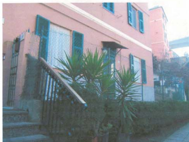
Esterni: Prospetto sul giardino
