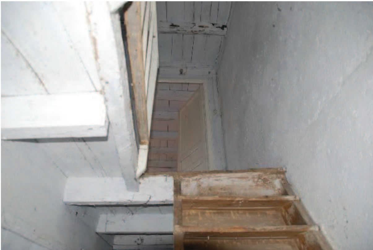
Foto 28 – Scala di accesso al P2
