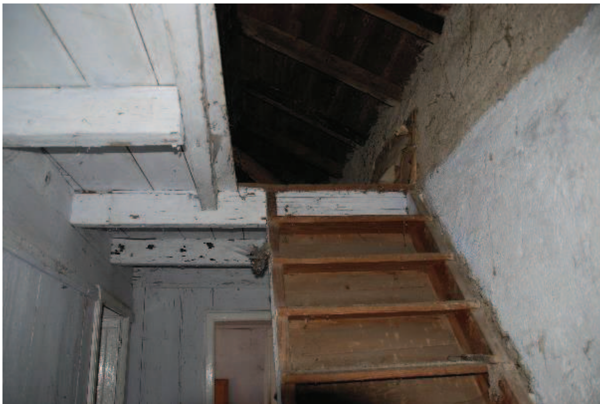
Foto 33 – Scala accesso locale Sottotetto
