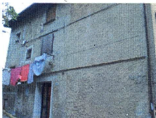
Edificio lato nord/est
