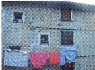
Edificio lato nord/est
