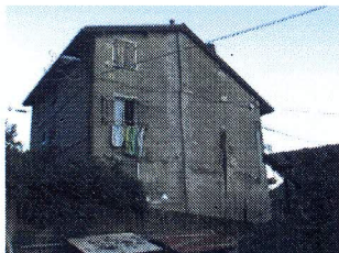
Edificio lato nord/ovest
