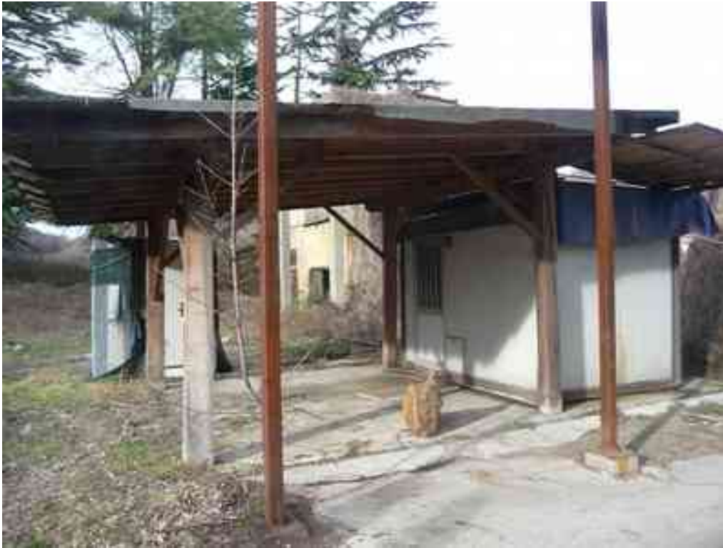
Foto n 7 Ufficio/Deposito con tettoia
