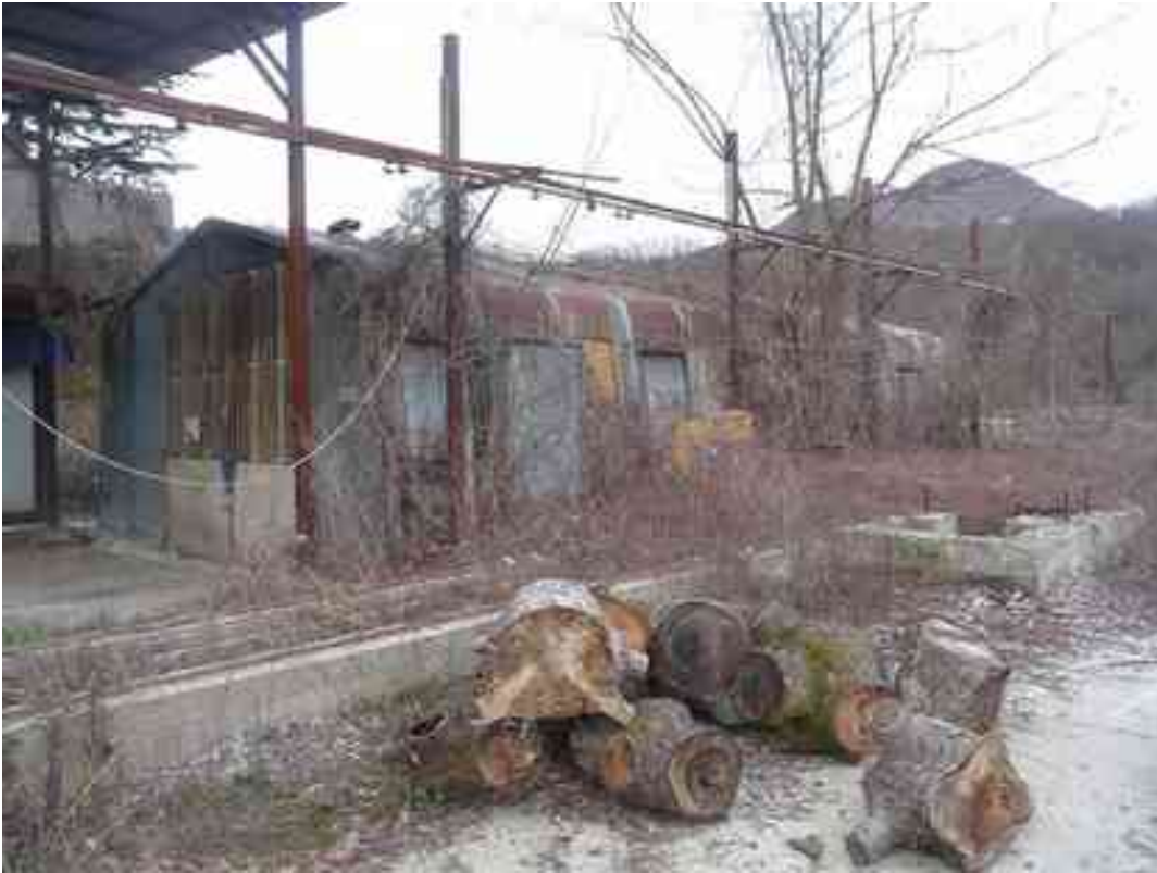
Foto n 5 Laboratorio lato sud dell'area
