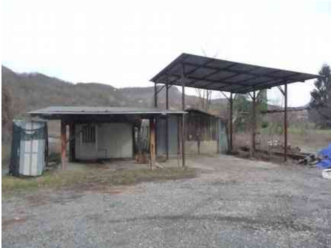
Foto n 1 Proprietà costituita da Laboratorio e Ufficio/Deposito con tettoie siti in Strada Statale 226 di Valle Scrivia - Savignone (Ge)
