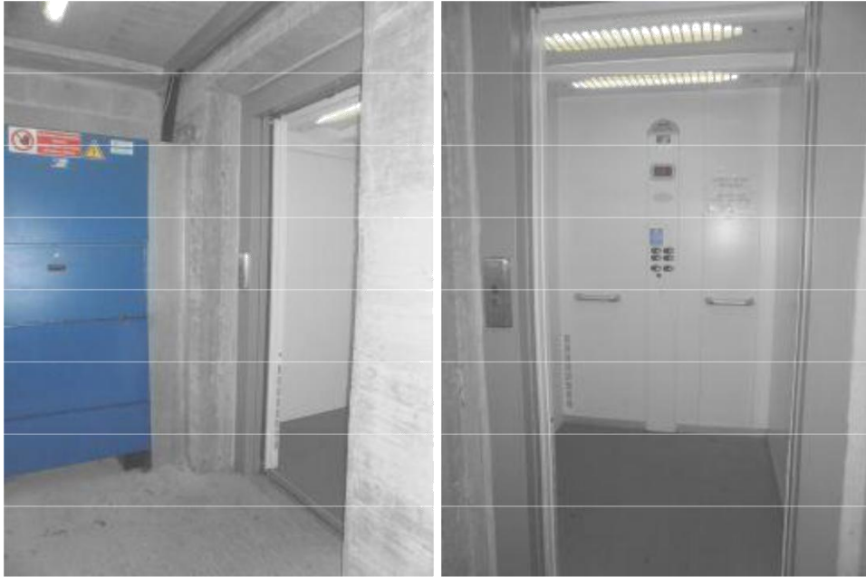
Ascensore a servizio piani 1° e 2° interrati
